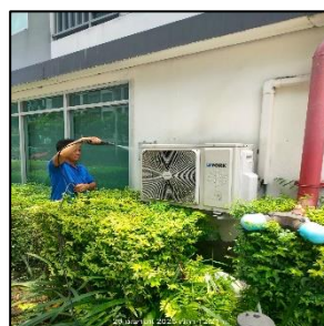
ภาพที่ 2.1-14 ล้างทำความสะอาดเครื่องปรับอากาศประจำปี
