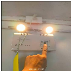
ภาพที่ 2.1-18 ระบบไฟฟ้าสำรอง
